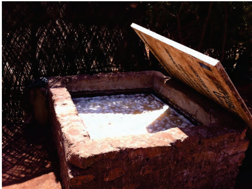
Photo 13 : bassin de fermentation en ouvrage maçonné utilisé pour le rouissage
