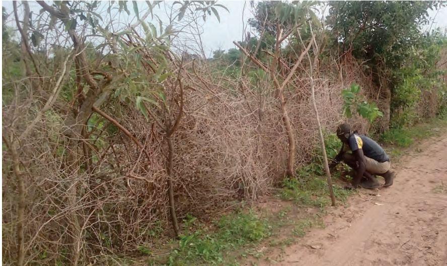
Photo 21: travaux d'entretien sur une clôture
