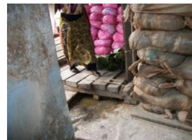
f) Condition de drainage des eaux dans un local de stockage
